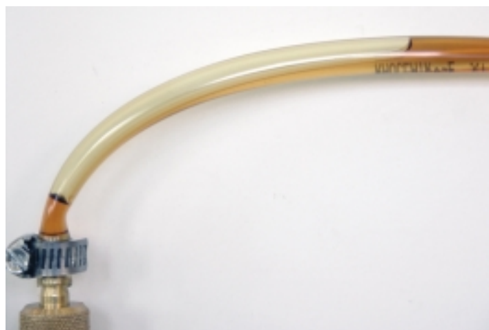
Luftabscheidungen haben sich im Einstrangbetrieb in einem Leitungsbogen gesammelt. Wenn die große Luftblase mitgezogen wird, kann der Brenner auf Störung gehen. Fotos: Keller
